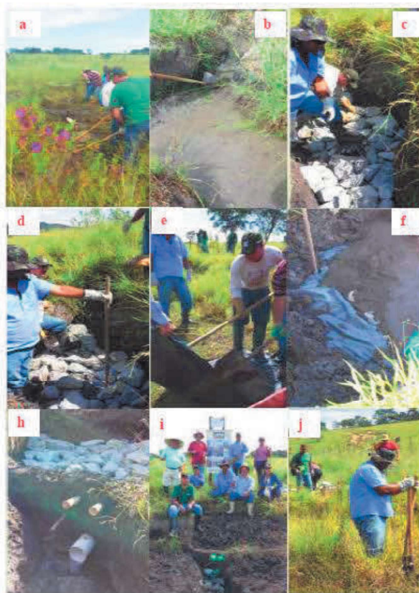
Figura 2 - etapas da recuperação e proteção de nascentes com solo-cimento: (a) limpeza da área da nascente; (b) desassoreamento da nascente; (c) nascente com brita nº 3; (d) instalação de tubulação para desinfecção da nascente; (e) preparo solo cimento na proporção 3 x 1; (f) cobertura da nascente com lona e solo cimento; (g) instalação da tubulação de captação, limpeza e extravasor e vedação da cabeceira com solo cimento; (h) nascente após intervenção recuperação; (i) nascente após intervenção recuperação; (j) plantio de mudas nativas para recomposição da área de mata ciliar e demarcação da área de proteção permanente com raio de 50 m.
