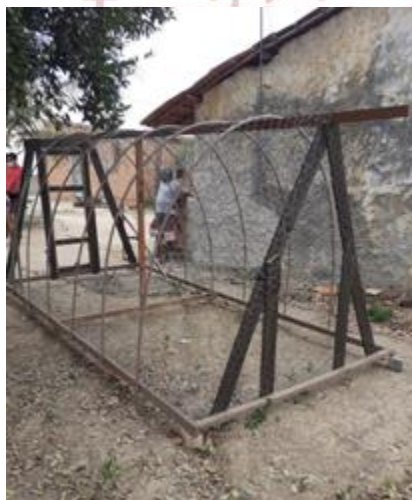
Figura 2. Galinheiro móvel com os canos e a tela instalados
